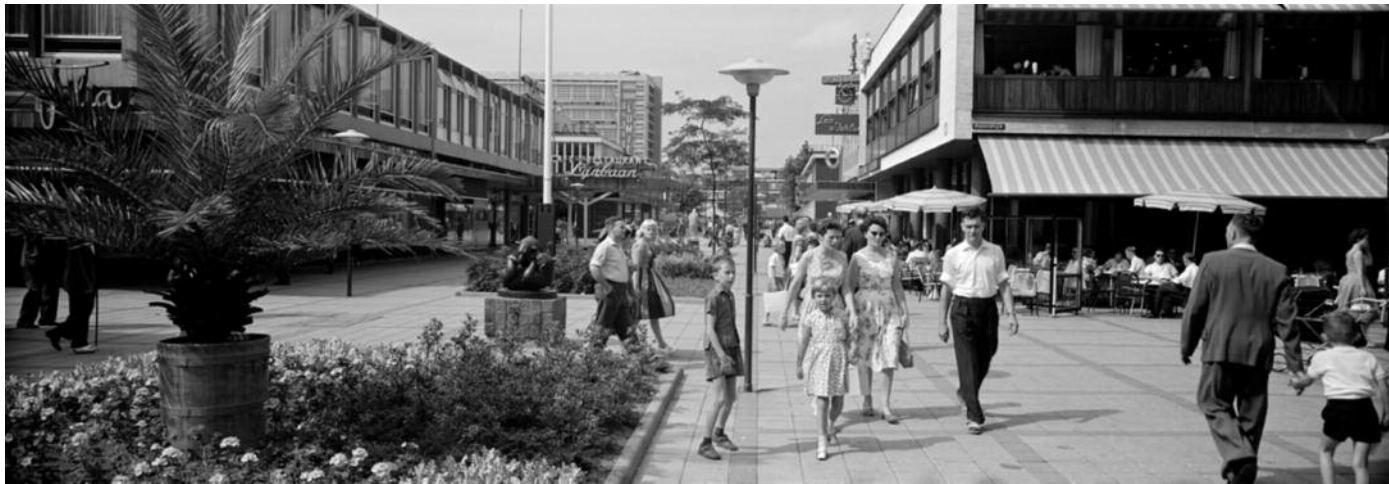
De in 1953 geopende Lijnbaan van architectenbureau Van den Broek en Bakema, ter hoogte van het Stadhuisplein, 1959.
