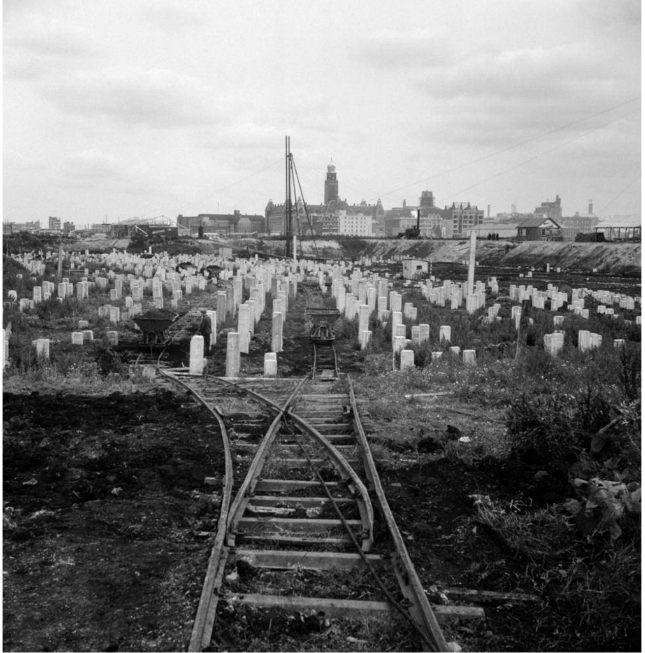
Heiwerkzaamheden voor het Groothandelsgebouw, Stationsplein/Weena, 1950. Op de achtergrond de torens van het stadhuis en de Laurenskerk. © KEES MOLKENBOER/NEDERLANDS FOTOMUSEUM
